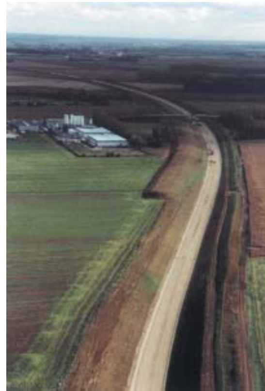
Utilisation pour les travaux TGV
