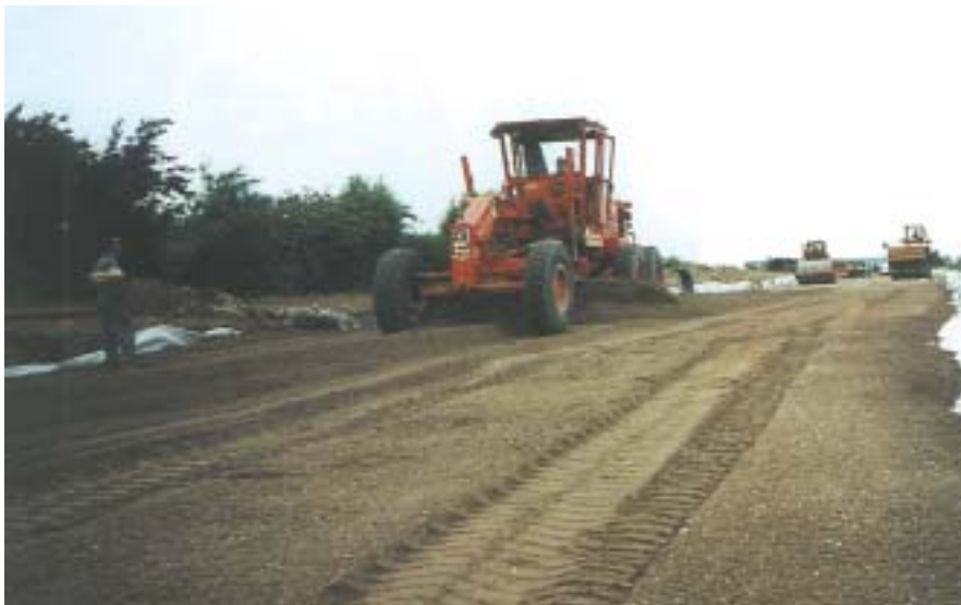
Utilisation de granulats recyclés en couche de fondation
