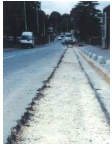
Remblayage de tranchée
