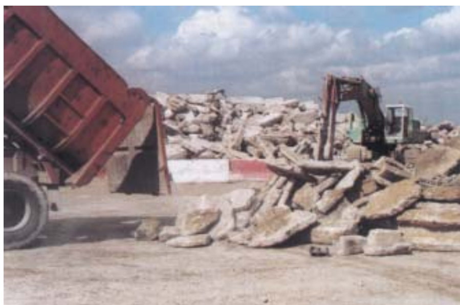
Réception des bétons de démolition
