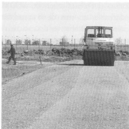
Utilisation de MIOM en couche de forme
