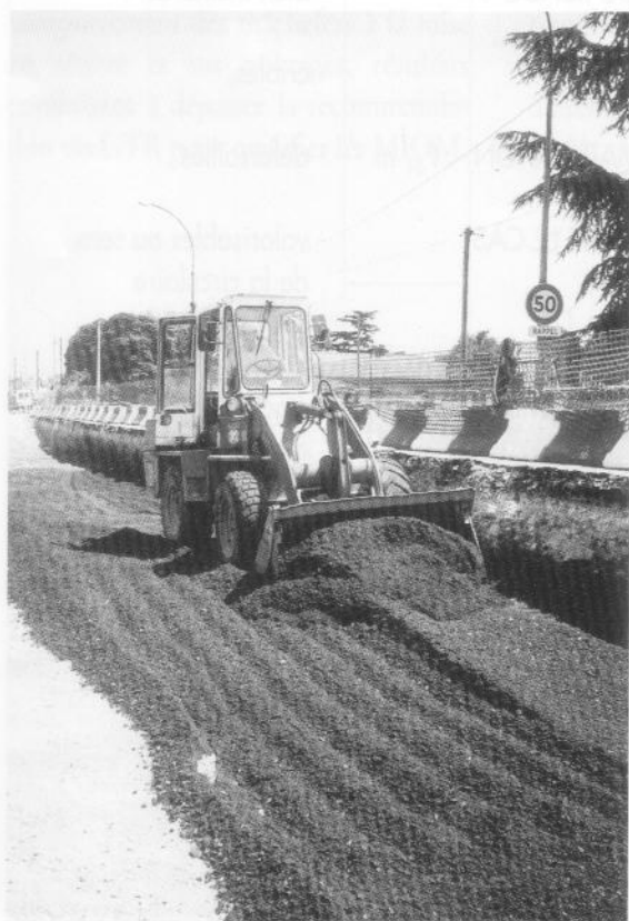
Utilisation de MIOM en assise de chaussée
