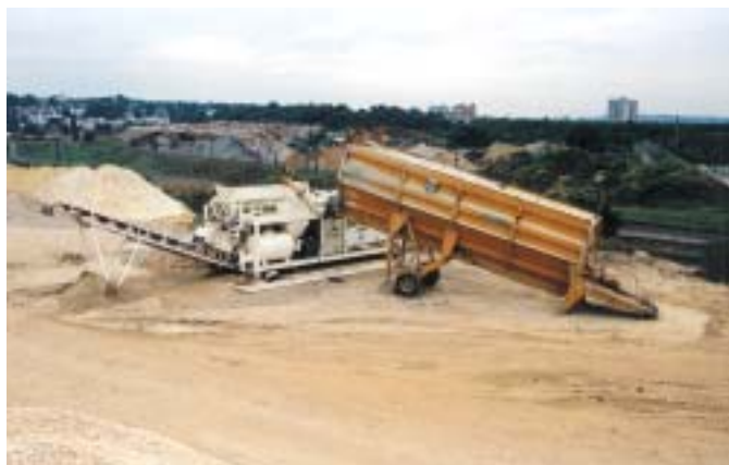
Installation semi-mobile SMS/MATRIF à Limeil Brevannes (94)
