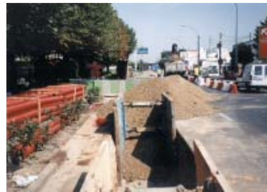
Exemple de réalisation de chantier en Ile-de-France
